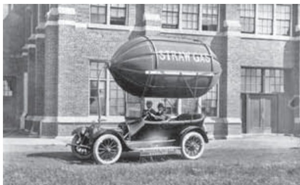
Рис. 1. Автомобиль, работающий на газе (продукте разложения соломы), хранящемся под низким давлением. Канада, 1918 г. (из коллекции Western Development Museum, wdm.ca)
